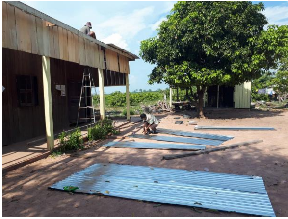
Die Dächer der Schule wurden durch einen Sturm beschädigt und werden repariert
