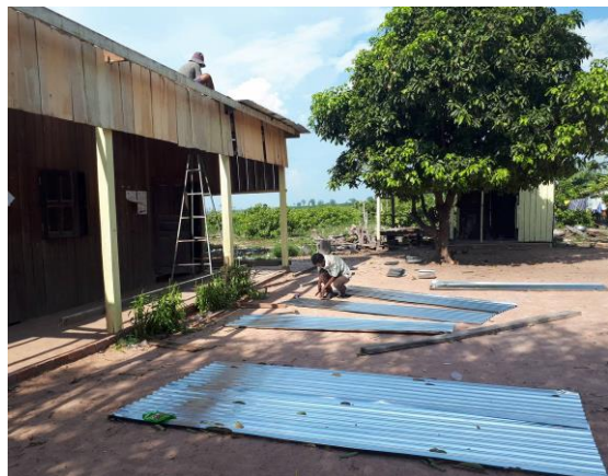
Das alte Dach wird ersetzt
